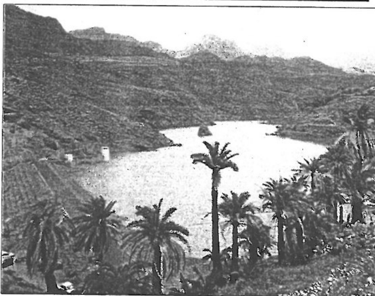
Presa de La Sorrueda, en Gran Canaria, víctima de uno de los últimos incendios de la Isla.
